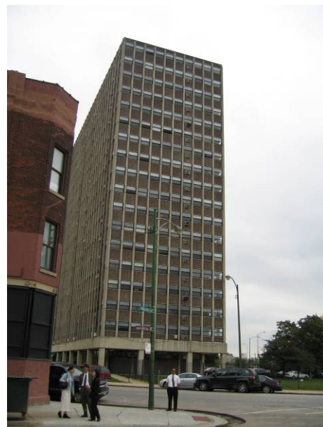
この建物の中の 9 部屋を運営。
